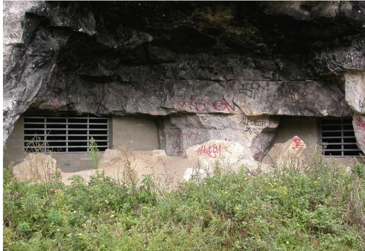
Pose de grilles pour préserver un lieu d'hibernation de chauves-souris à Vattier-Voisin (Photo C. GALET)
