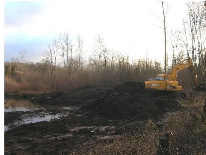
Décapage mécanisé des horizons superficiels en zone humide à Fresnoy-la-Rivière (Photo Conservatoire d'espaces naturels de Picardie)
